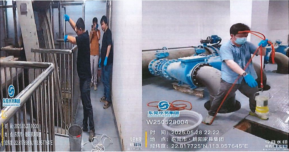
本期工程进水口
