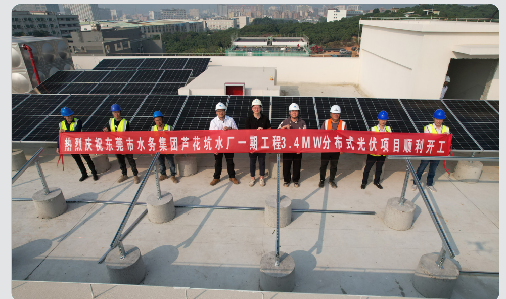
芦花坑水厂分布式光伏项目开工
