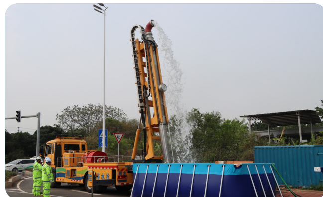
管网公司开展排水防涝应急演练
