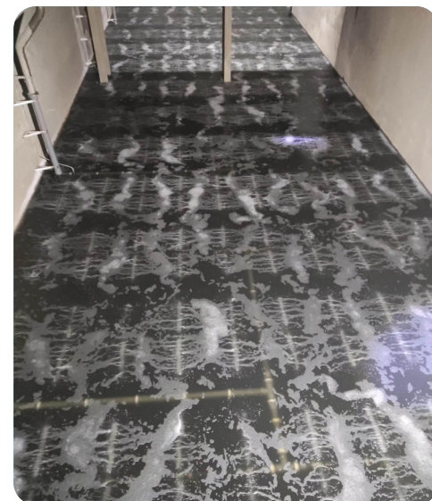
桥头水质净化厂测试生化池更换的曝气管曝气效果
