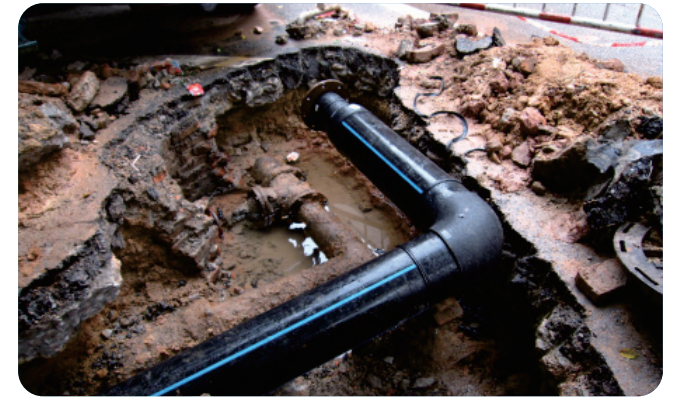
管网改造新旧管对比
