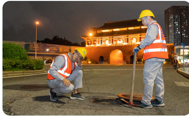
供水探漏检测
