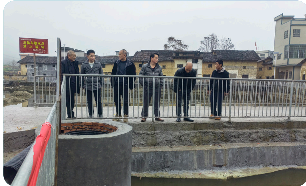
工作队检查梅花镇污水管网建设情况
