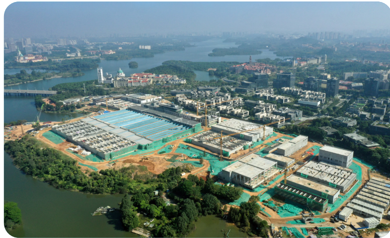
珠三角水资源配置工程松湖水厂一期工程
