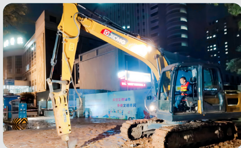
供水管道抢修作业现场
