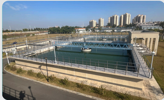
第五水厂排泥水项目
