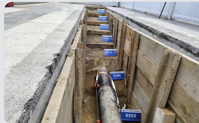
管改一期（万江标段）管道回填材料压实
