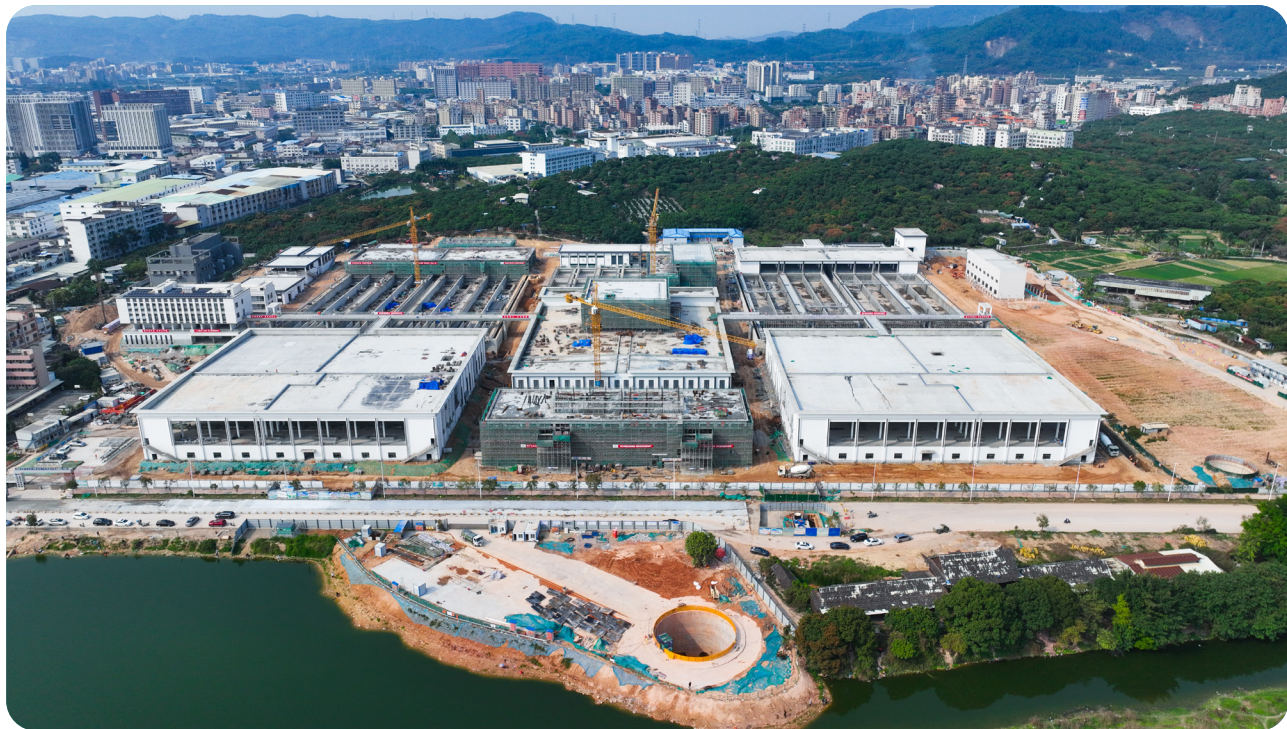
珠三角水资源配置工程芦花坑水厂一期工程
