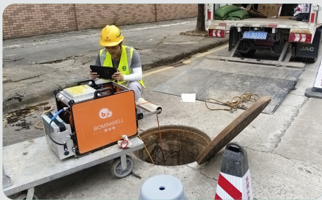
检测小组在进行管道 CCTV 检测作业
