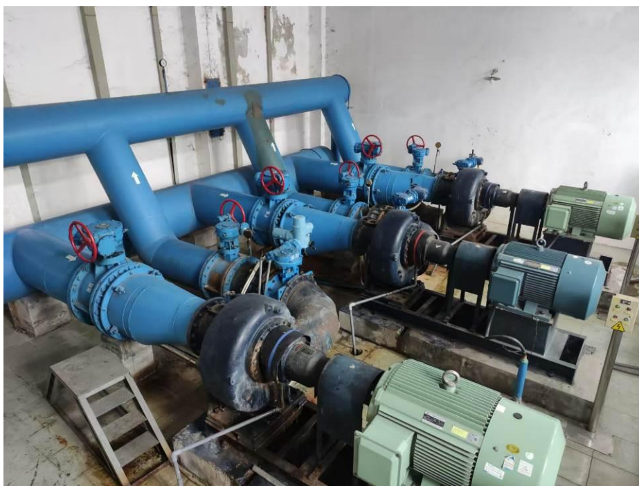
图 3.6 三期滤池反冲洗泵房
