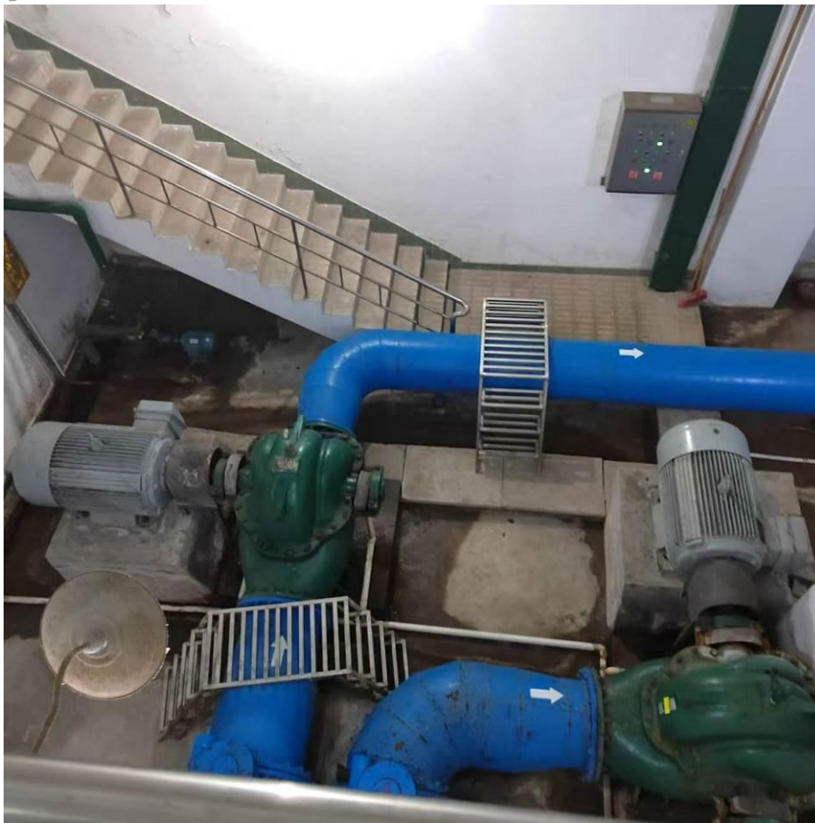
图 3.4 二期滤池反冲洗泵房
