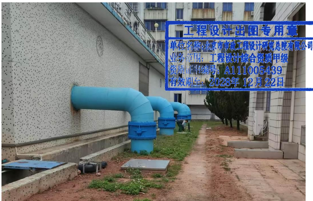
图 3.1 反应池 DN800 进水阀
