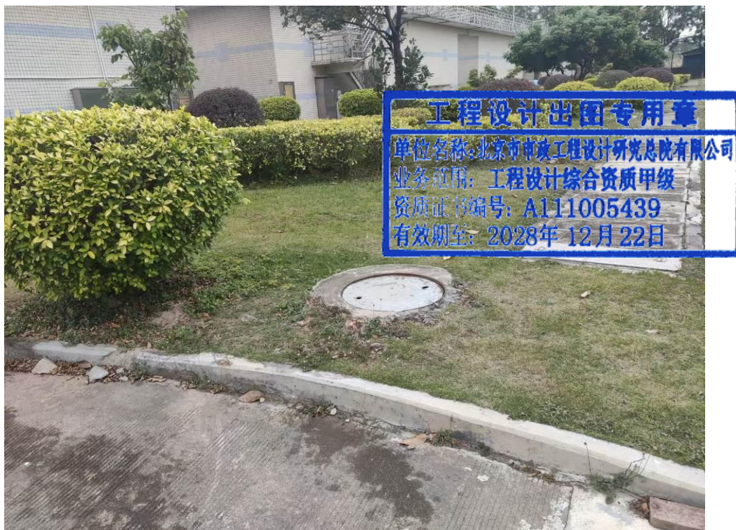
图 3.1 厂平面 DN1400 阀门井
