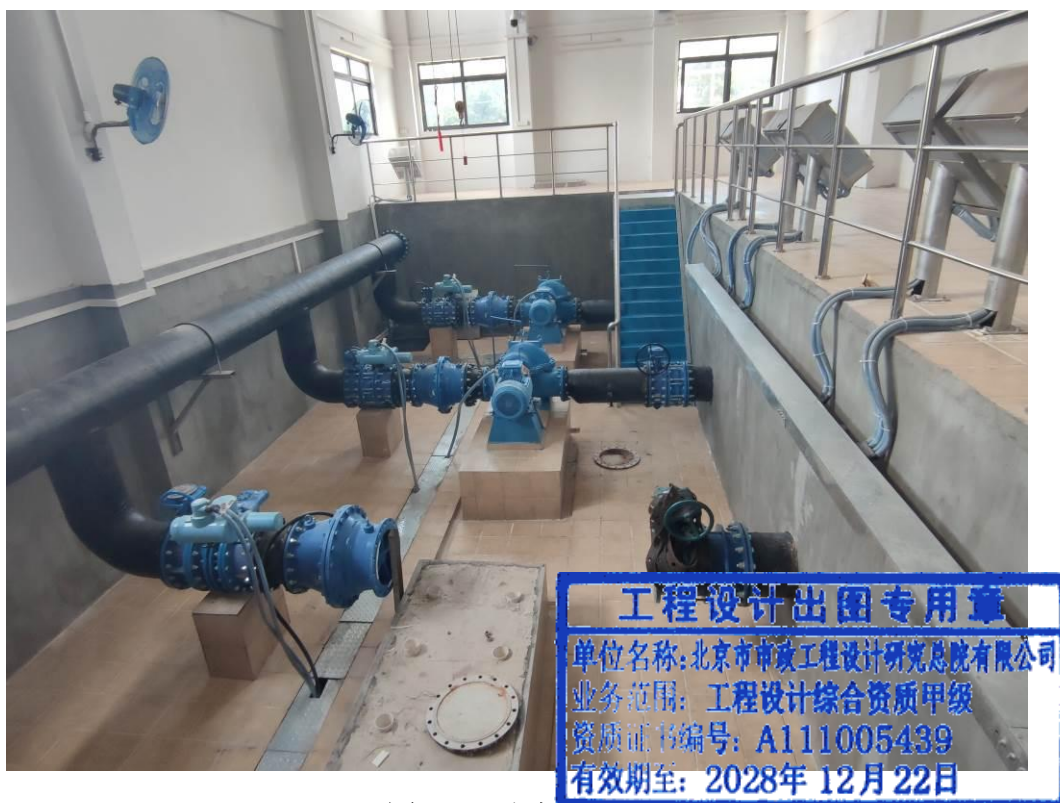
图 3.2 反冲洗泵房
