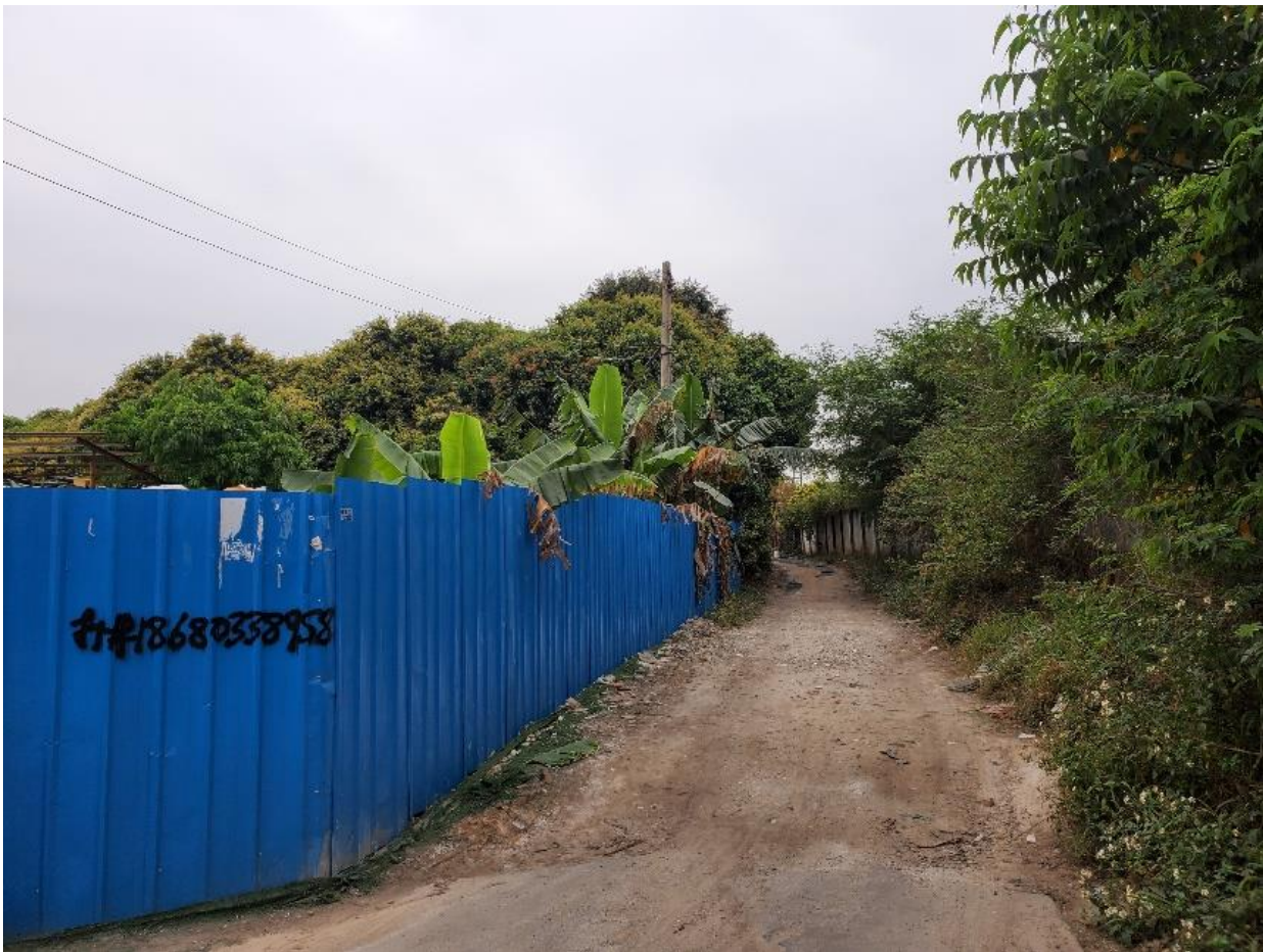
图 7.2-17 铁路东侧草朗街附近顶管井附近现状图
