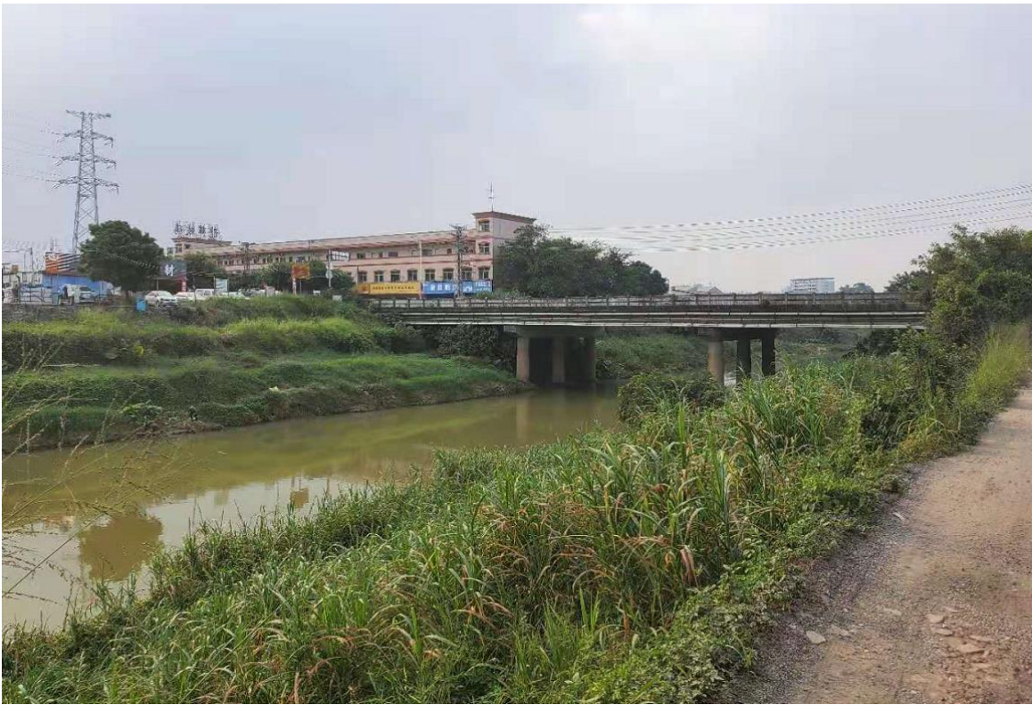
图 7.2-5 石马河现状桥梁（环市东路）
