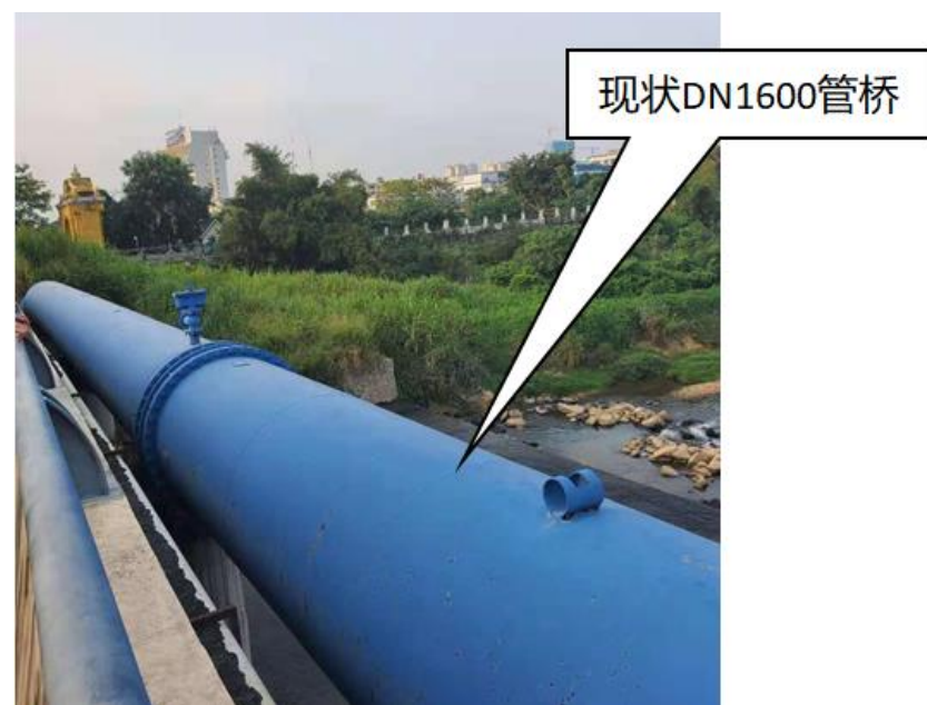
图 8.1-5 观澜河北侧现状管线
