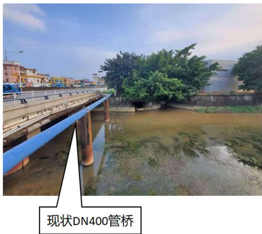
图 8.1-4 观澜河南侧现状管线
