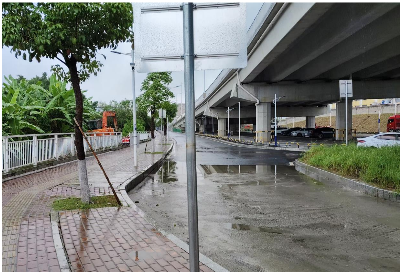
图 7.2-11 环市南路高架北侧现状辅道图
