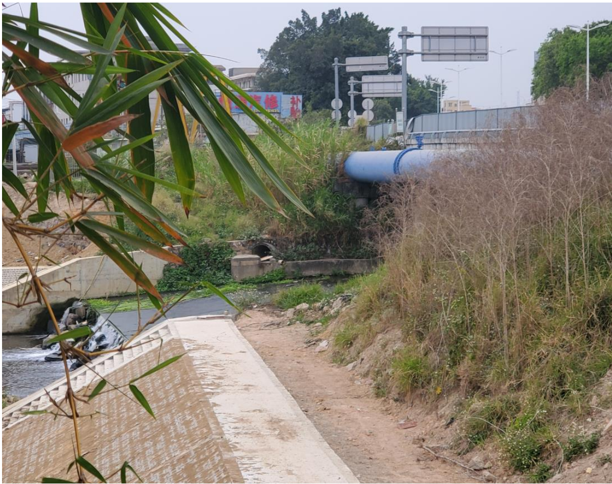
图 7.2-14 管桥 1 位置现状图
