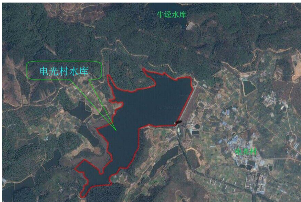
图 6.3-1 电光村水库航拍图
