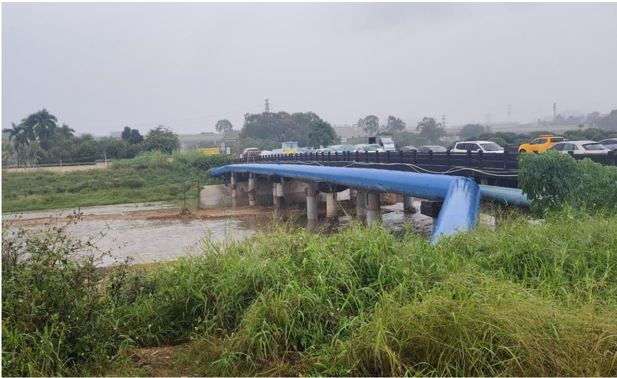
图 7.2-15 管桥 2 位置现状图
