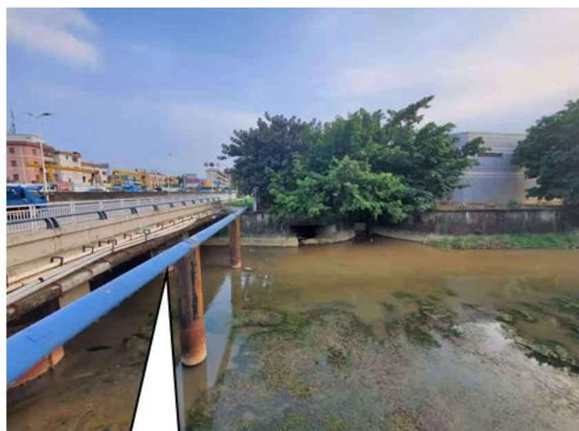
现状DN400管桥
