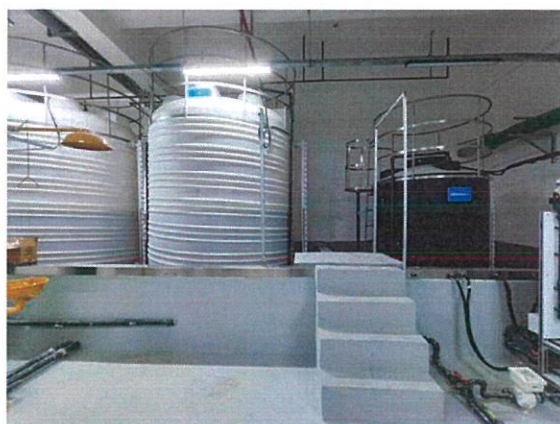
储罐设有围堰，有效防止泄漏
