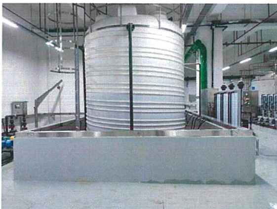
储罐设有围堰，有效防止泄漏
