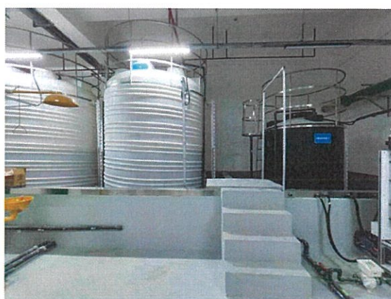
储罐设有围堰，有效防止泄漏
