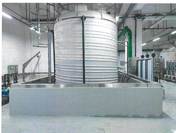
储罐设有围堰，有效防止泄漏
