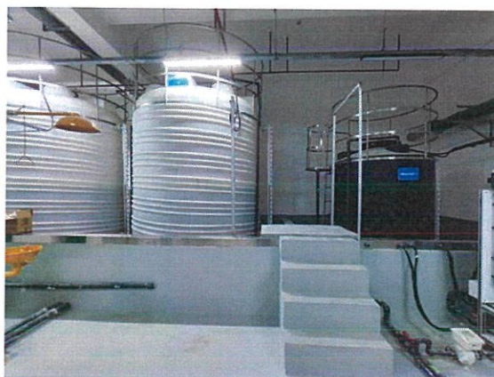
储罐设有围堰，有效防止泄漏
