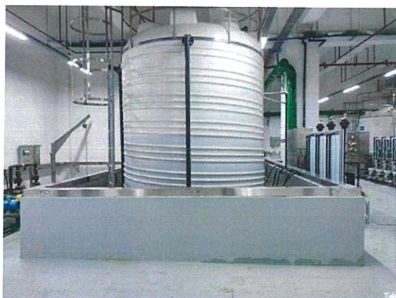
储罐设有围堰，有效防止泄漏
