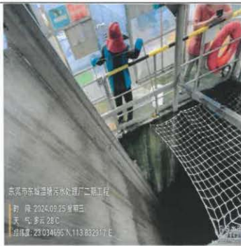
本期工程进水口
