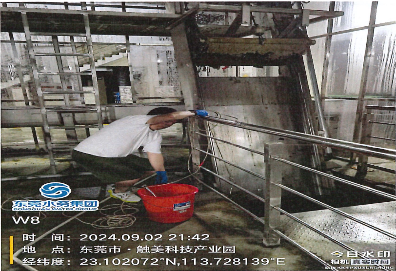
本期工程进水口
