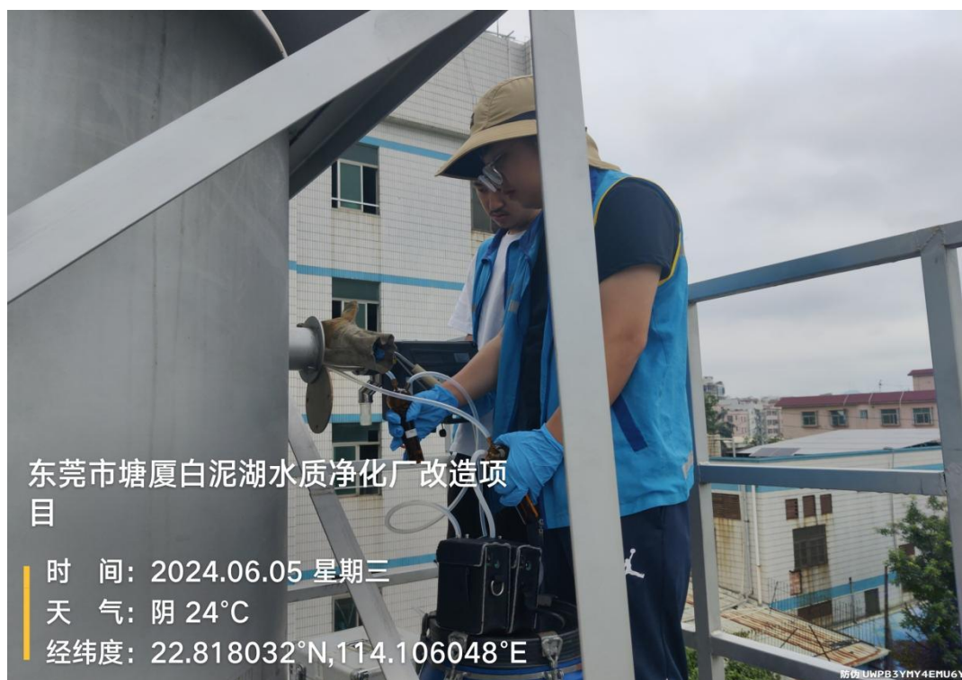
恶臭废气排放口
