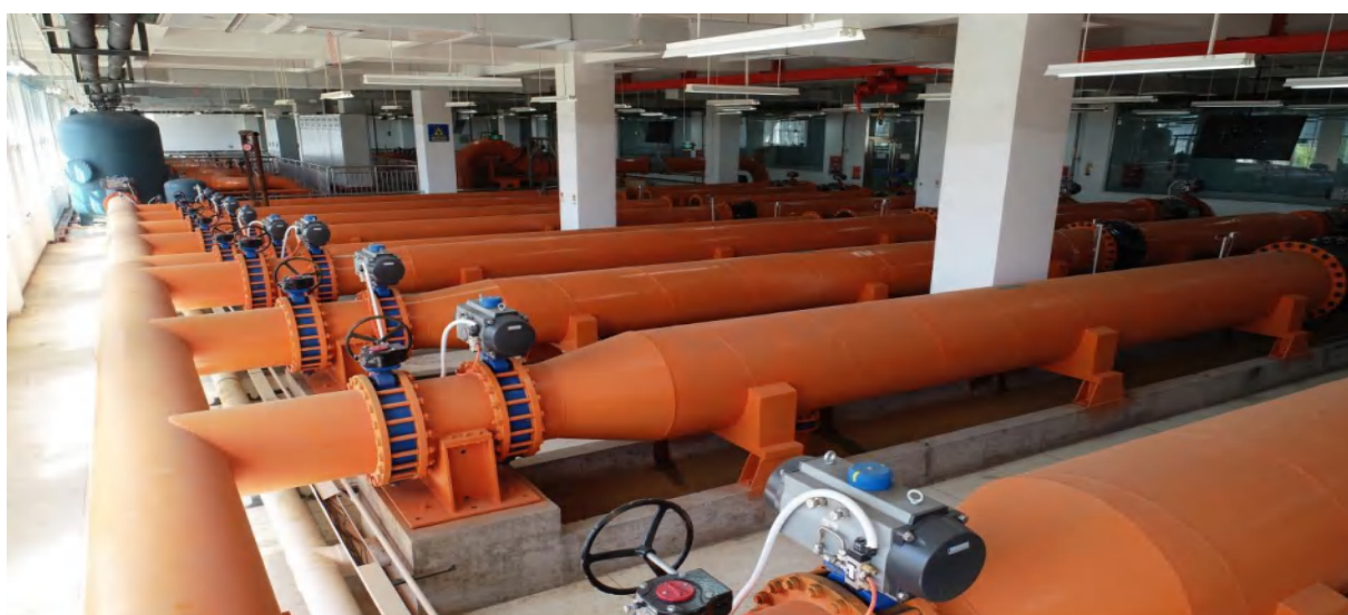
水表智能化检定车间
