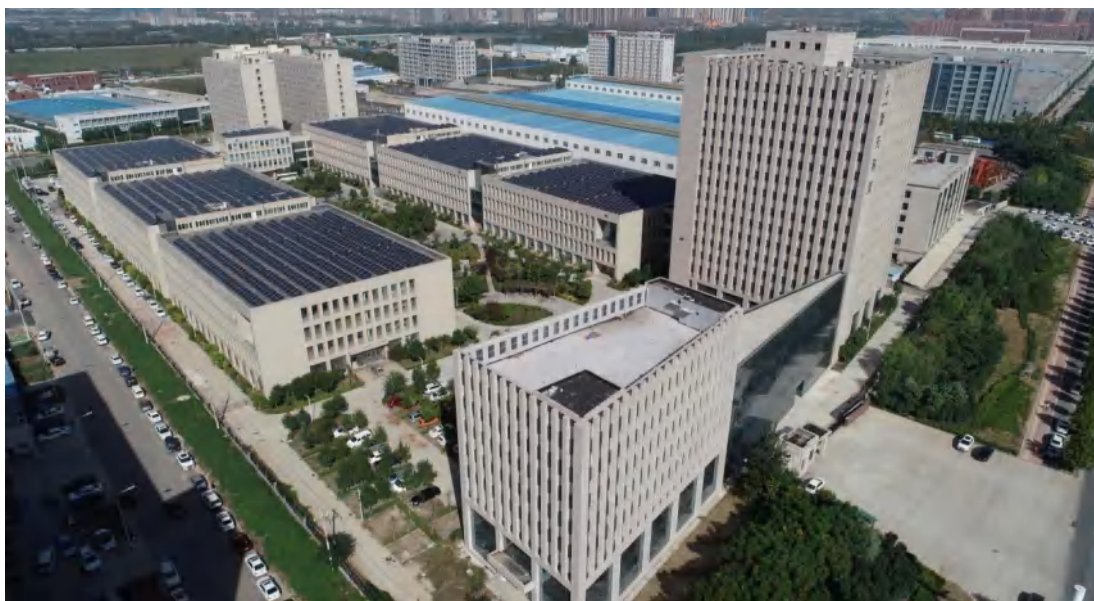
厂房外部图片 1
