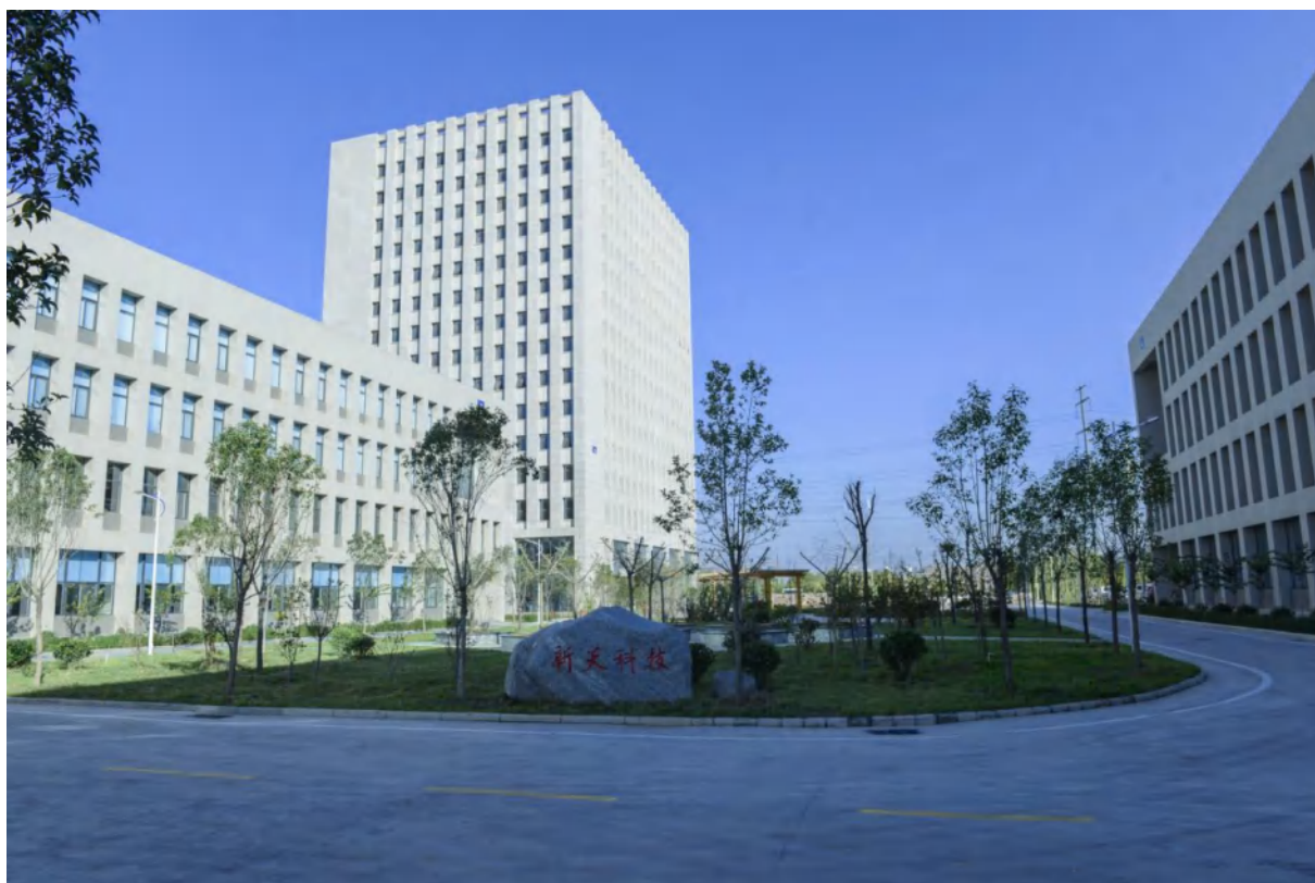
厂房外部图片 5
