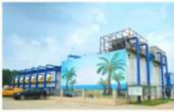
大石污水系统一体化水质净化工程
