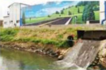
板桥涌污水系统一体化水质净化工程
