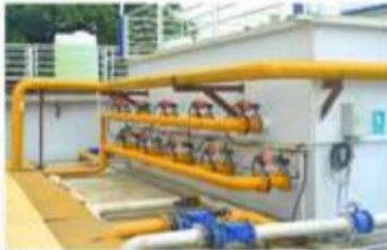
金山村污水系统一体化水质净化工程
