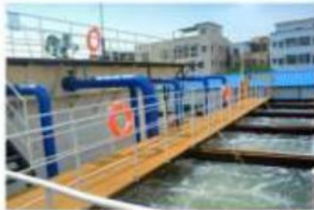
沙溪涌污水系统一体化水质净化工程
