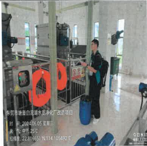
厂内浓度最高点(粗格栅及进水泵房)
