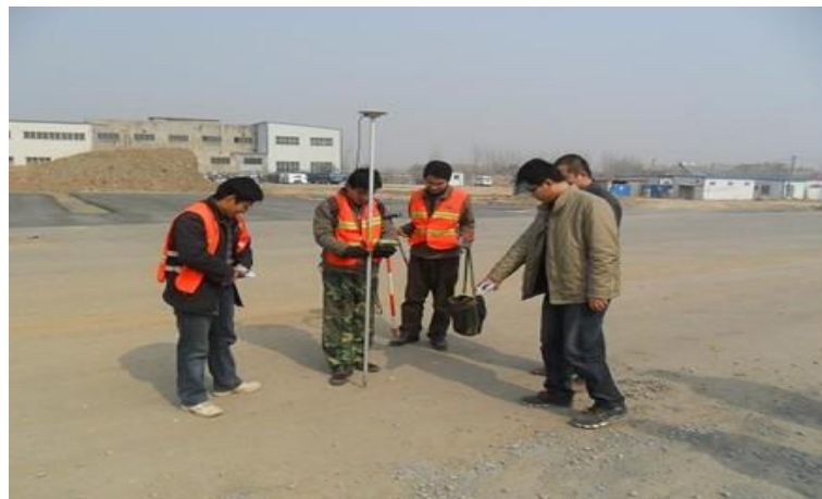
现场交桩实例图
