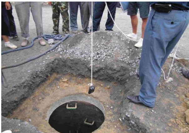
检测井内有毒气体浓度实例
