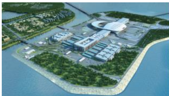
港珠澳大桥澳门口岸管理区项目旅检大楼
