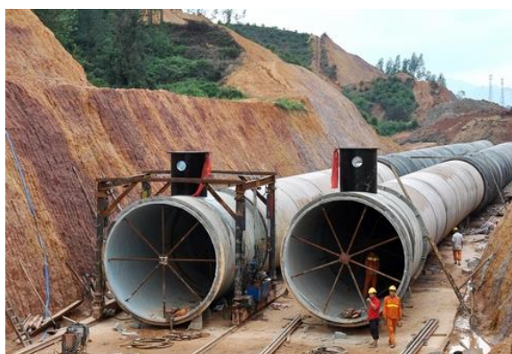
广州西江引水工程
