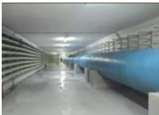
肇庆新区地下综合管廊
