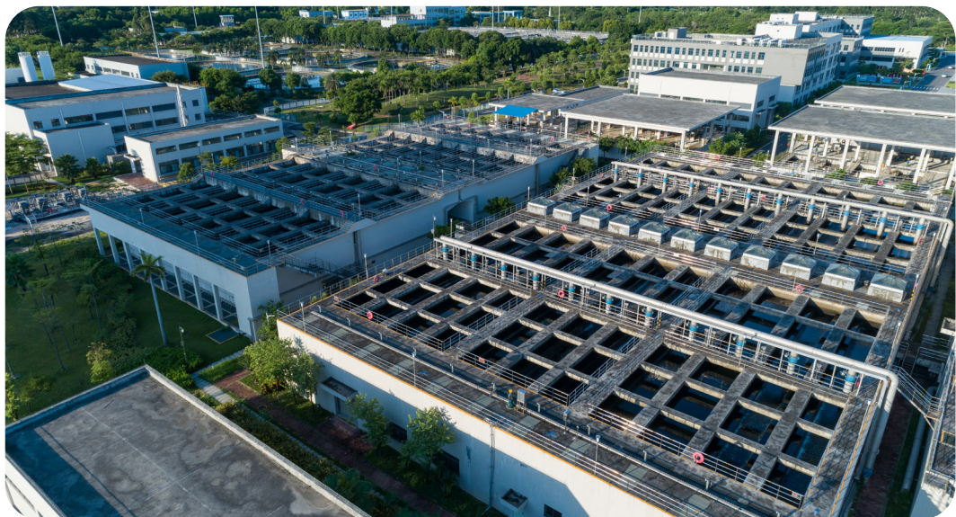
水务集团市区污水处理厂提标项目
