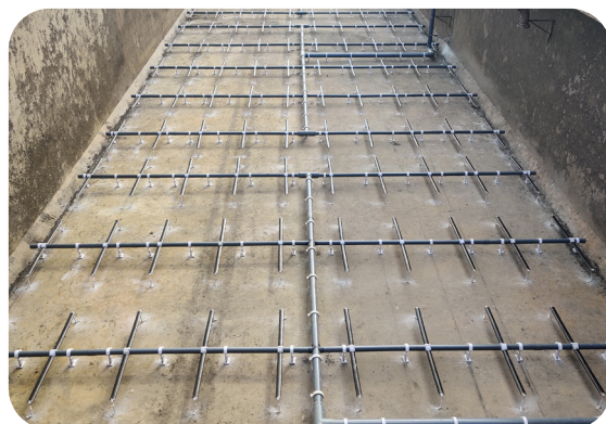
曝气系统更换后
