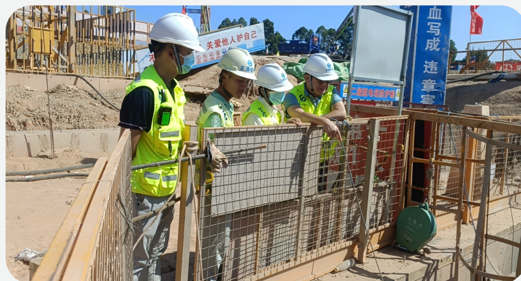
为提升正源公司人员检测能力，进一步推动与深水检测公司在检测领域的深度合作，双方通过现场教学交流，积极推动珠三角配套工程松山湖水厂的检测工作进度。
