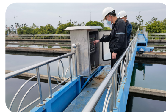
对自来水厂生产设备设施进行检查
