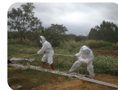
工程公司支援抗疫应急工程
