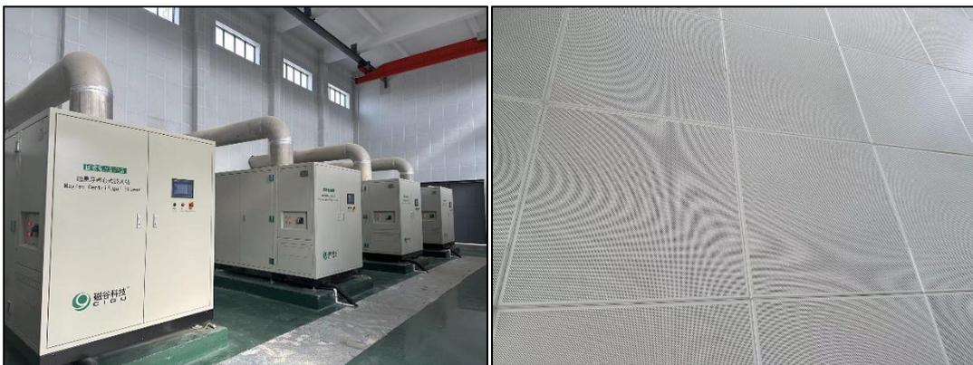
图 4.1-12 鼓风机房墙体采取隔音棉材料
