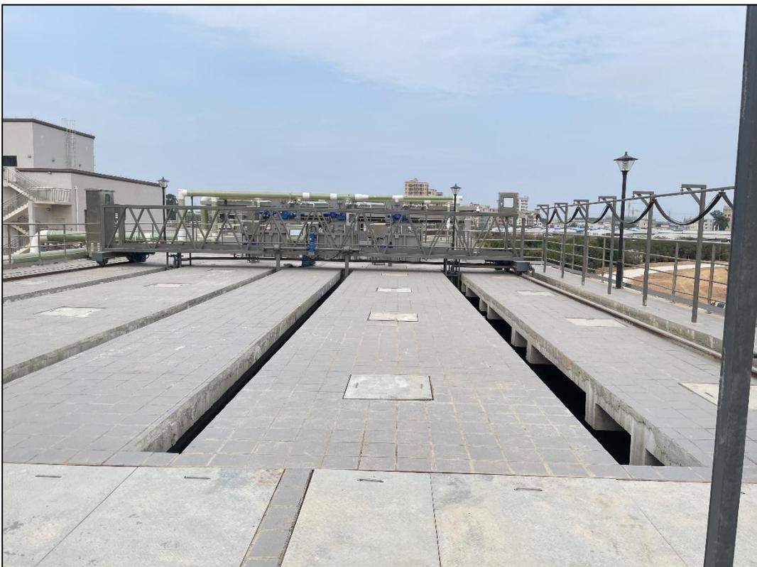
图 4.1-2 细格栅及曝气沉砂池
