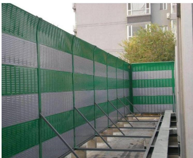
图1-7 隔音屏示意图
