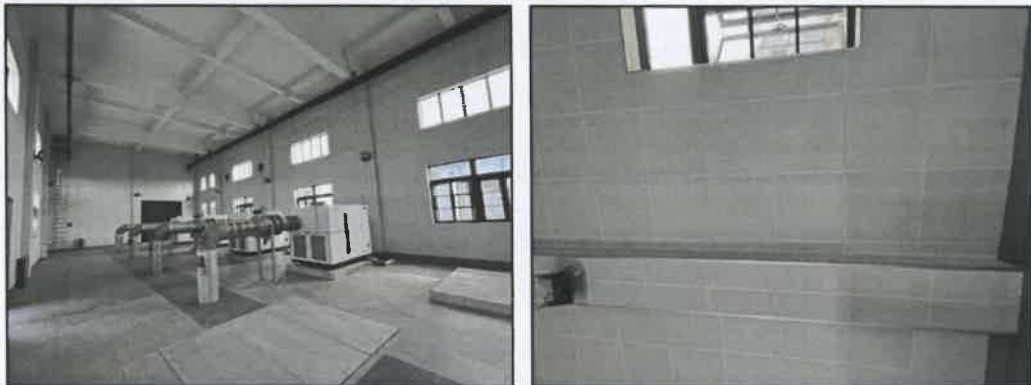
图 4.1-12 风机房墙体采取隔音棉材料
