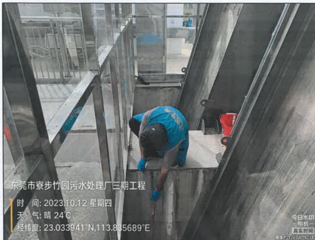
图 9.2-1 三期工程进水口
