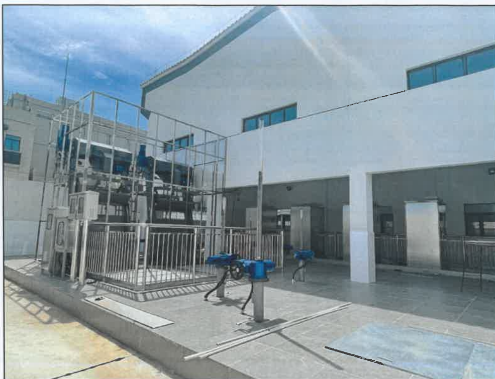
图 4.1-1 粗格栅及进水泵房
