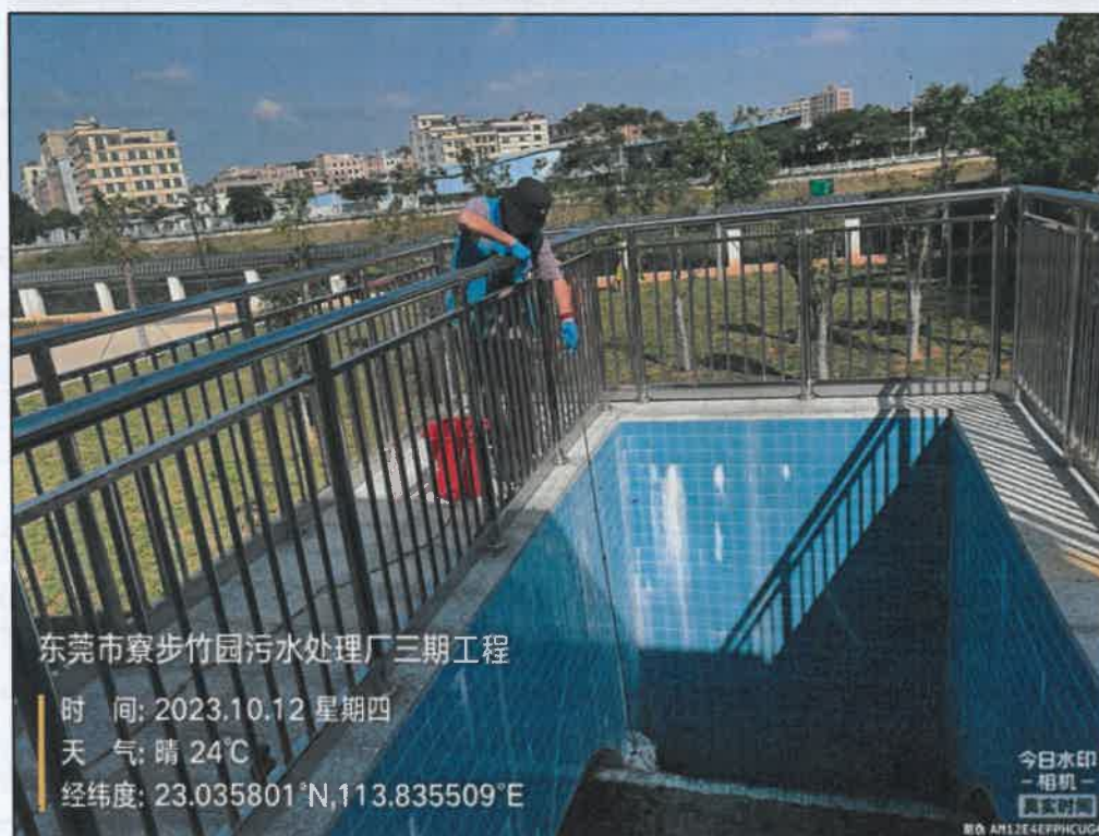
图 9.2-2 三期工程出水口
