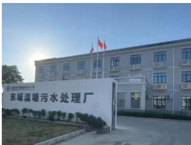
西面为东城污水处理厂
