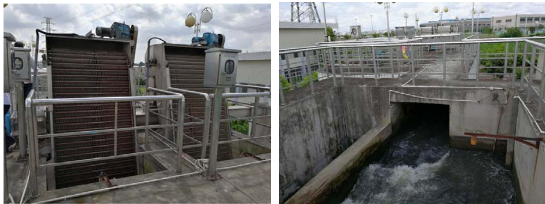
图2.3-11 茶山镇污水处理厂一期细格栅（左）及旋流沉砂池（右）现状图
