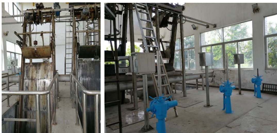
图2.3-10 茶山镇污水处理厂一期粗格栅（左）及进水泵房（右）现状图
