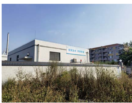
图8.7-12 余屋泵站现状
