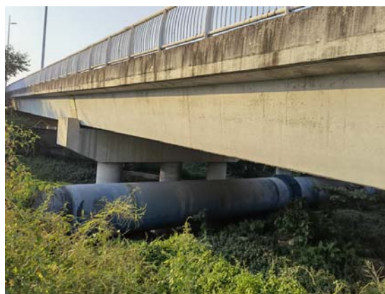
图8.7-8 现状给水管现状
