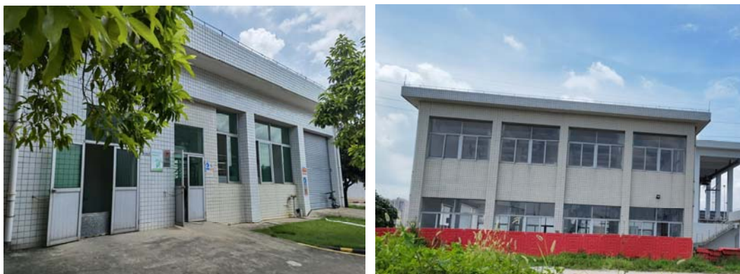
图6.7-1 茶山镇污水厂现状建筑风格
