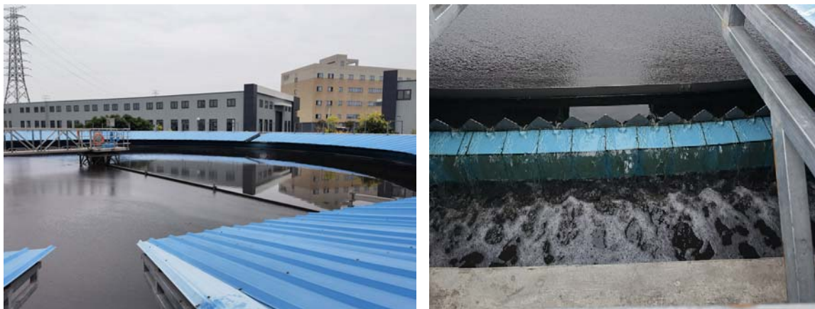
图2.3-13 茶山镇污水处理厂一期二沉池现状图
