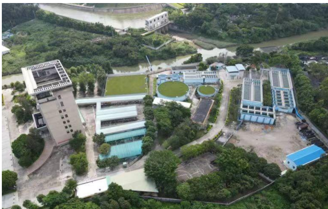
图 3.14-1 塘厦中心水厂现状照片
