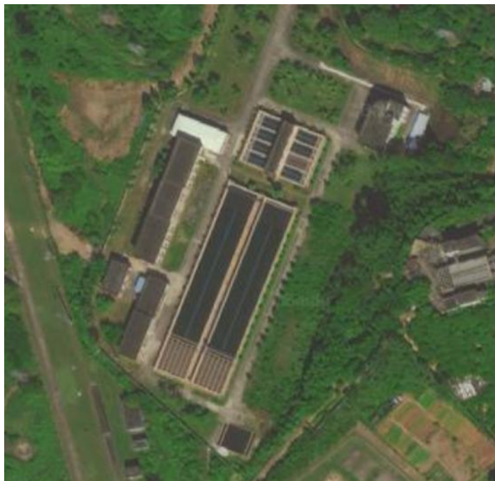
图 3.11-1 凤岗第二水厂卫星图
