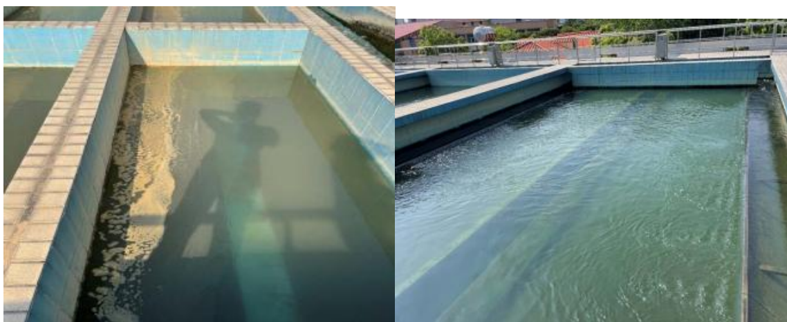
图 3.2-1 中堂水厂构筑物现状照片
