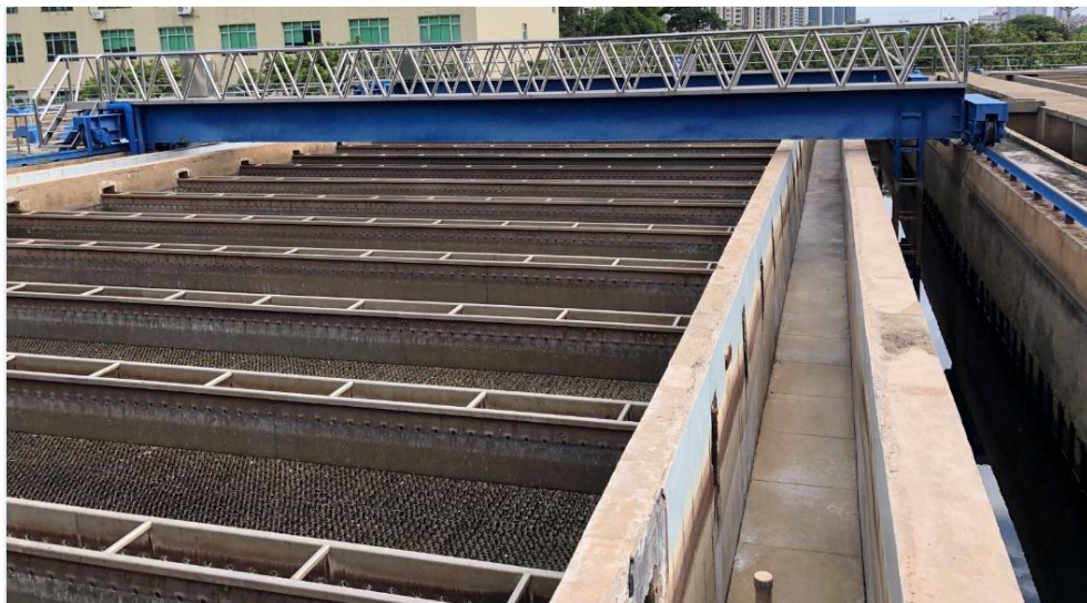
图 4.6-1 现状斜管沉淀池
