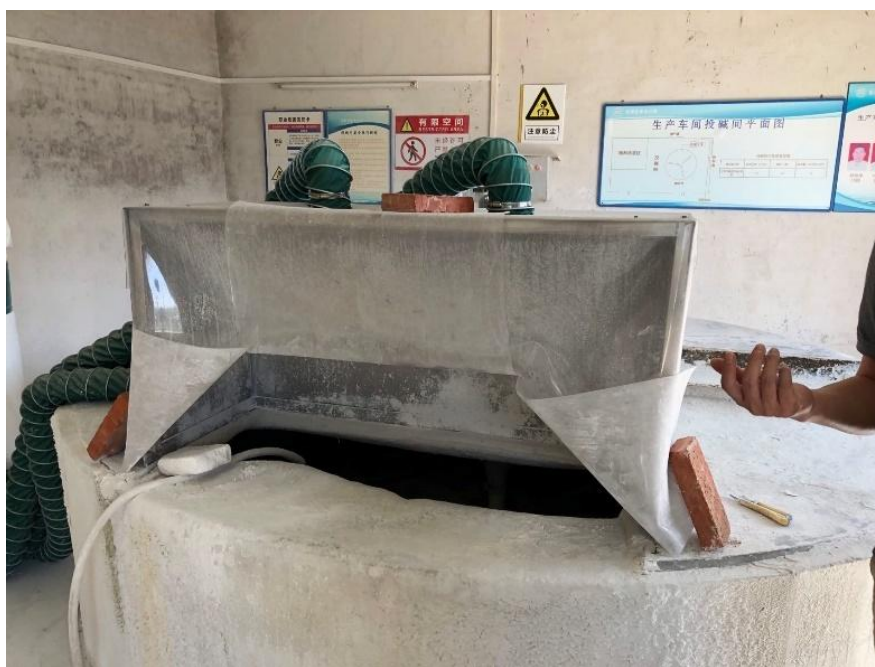
图 3.9-4 石灰投加系统
