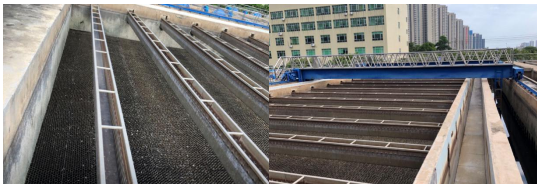
图 3.7-2 一期斜管沉淀池
