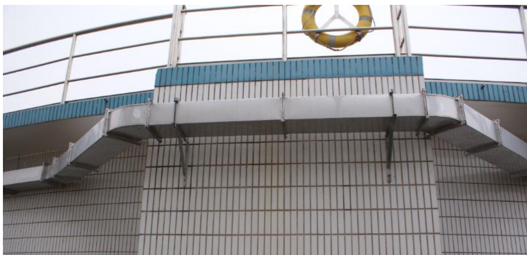
图 6.8.6-1 不锈钢风管沿墙壁安装示例
