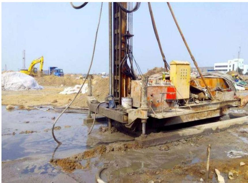
图 7.3-5 水泥深层搅拌桩示意图
