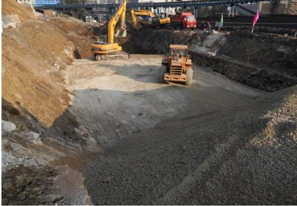
图 7.3-1 垫层换填示意图
