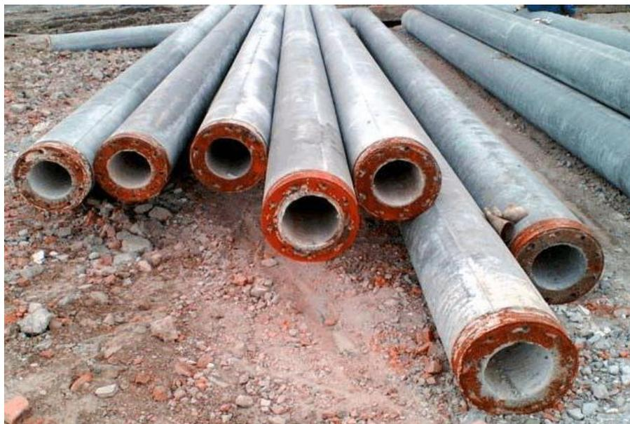
图 7.3-2 管桩示意图
