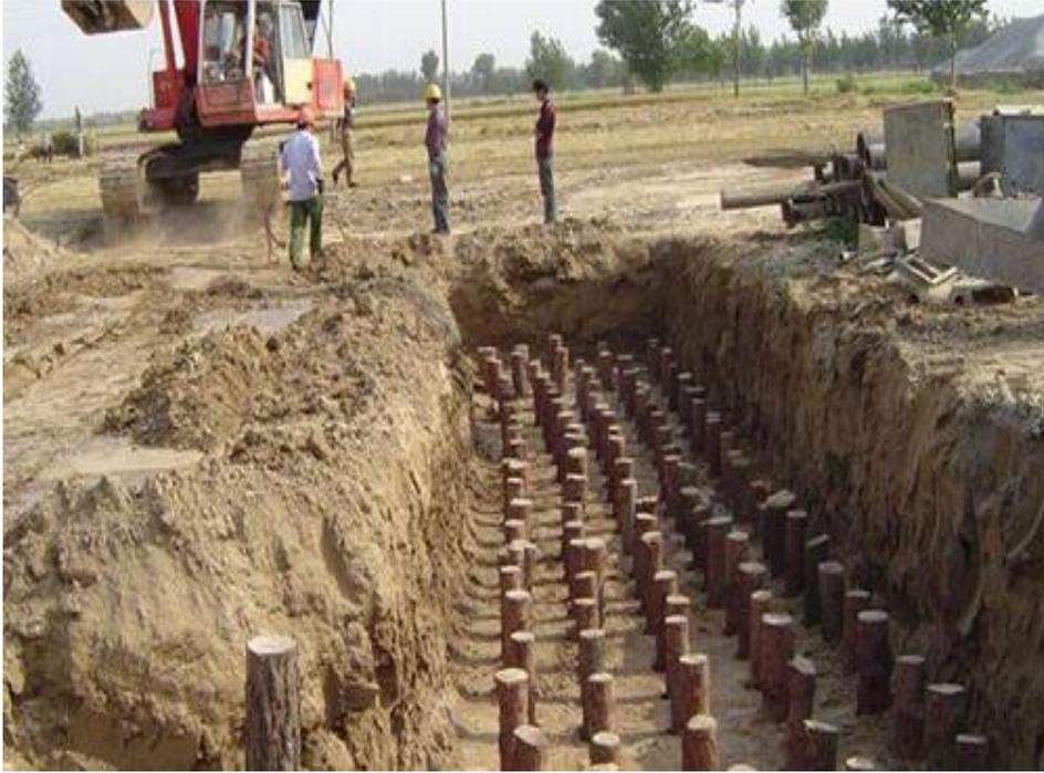
图 7.3-4 木桩发施工示意图
