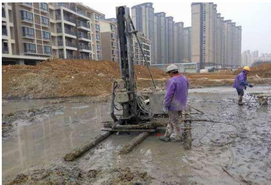
图 7.3-6 深层高压旋喷桩示意图
