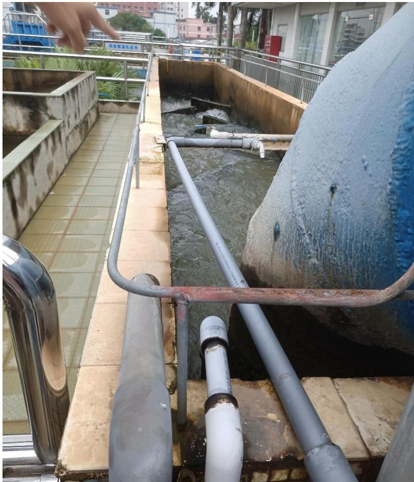
图 8-15 反冲洗废水回用点推荐
