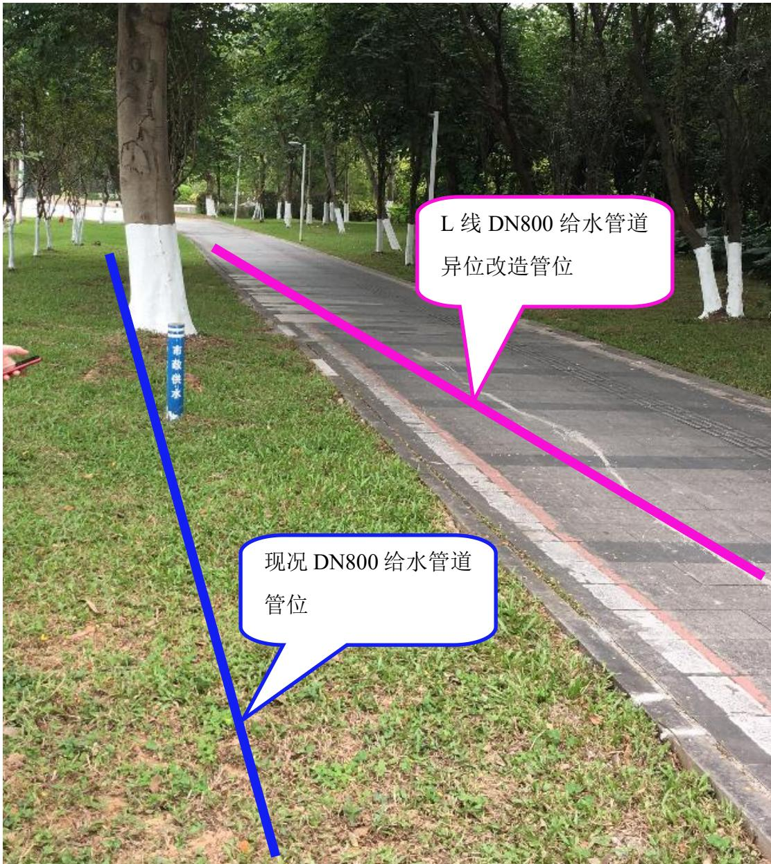
图 7-47 L 线管道路由示意图
