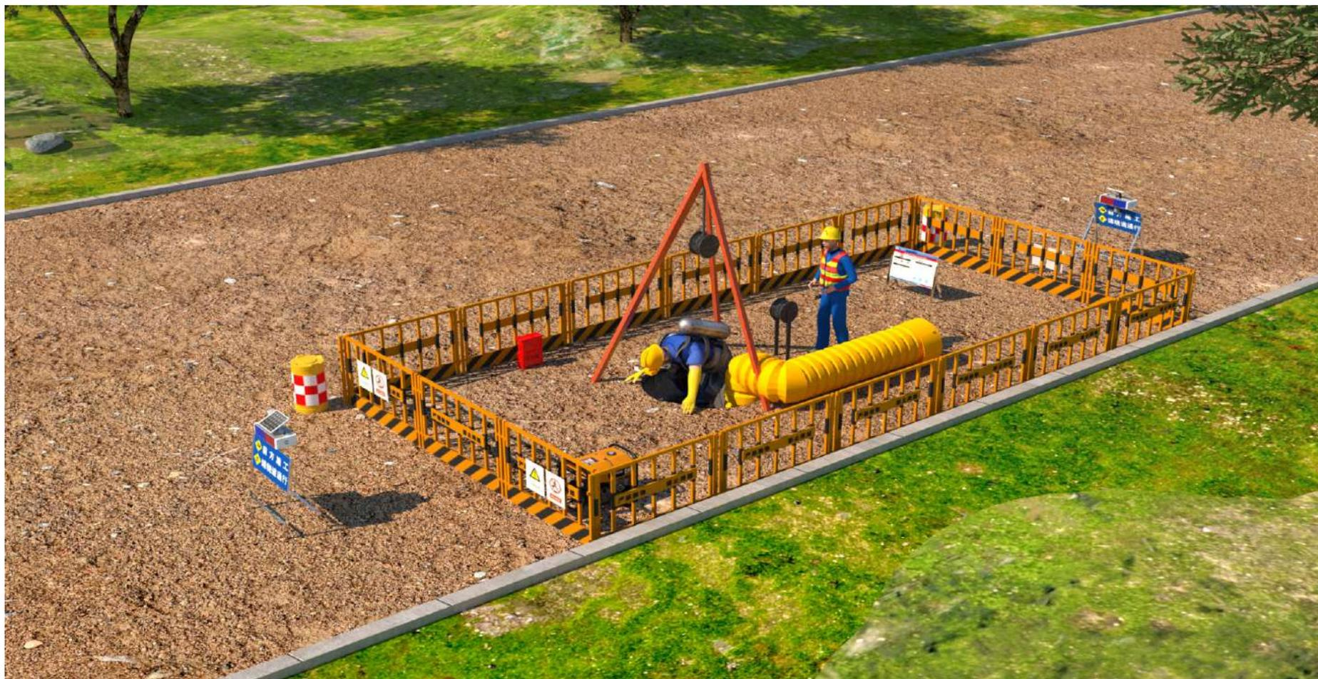
郊外管网维修工程（工期 $\leq 1$ 天）作业区域内部标准化（检查井维修施工）示意图
