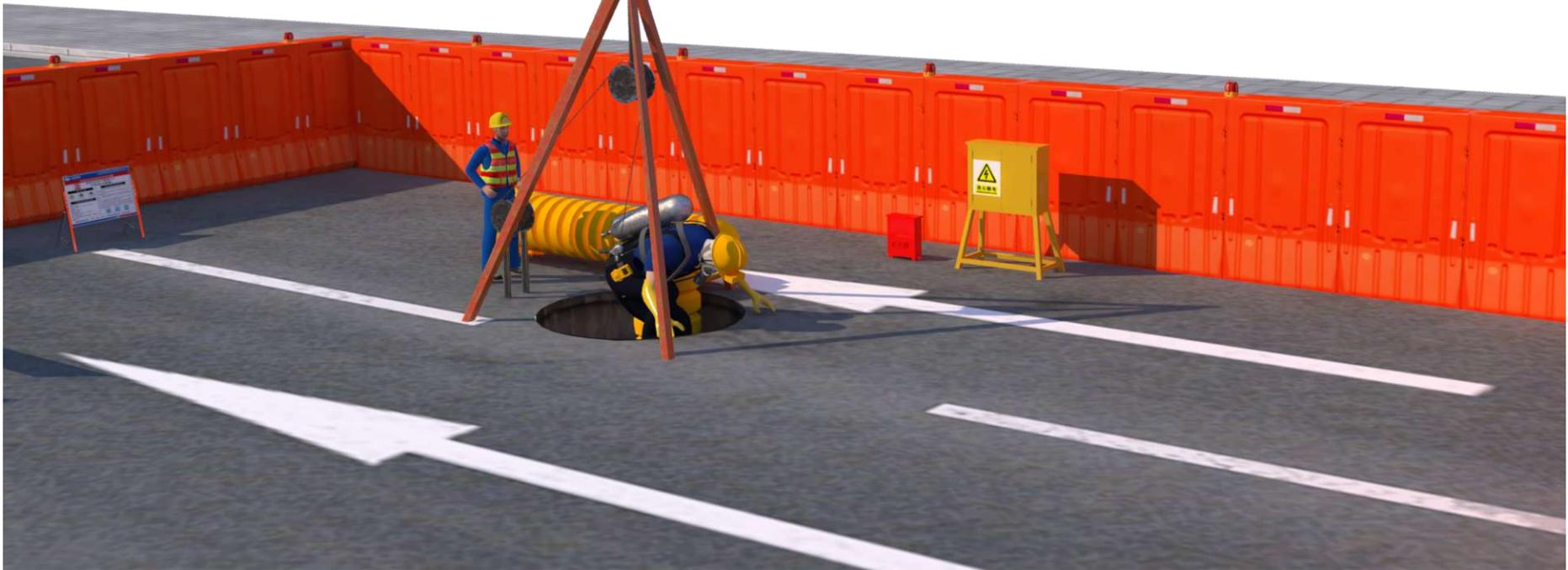
作业区域内部标准化（检查井维修施工）示意图
