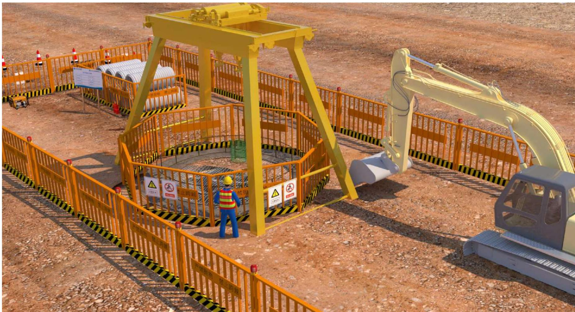
郊外管网维修工程（工期>1天）作业区域内部标准化（顶管施工）示意图
