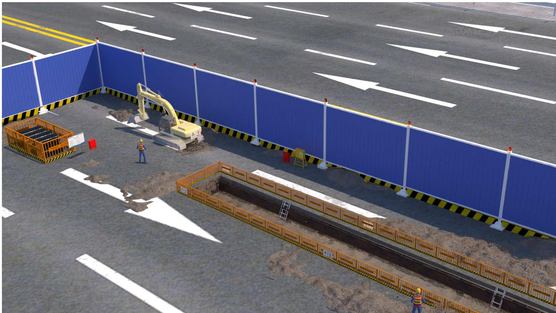
作业区域内部标准化（管道开挖施工）示意图
