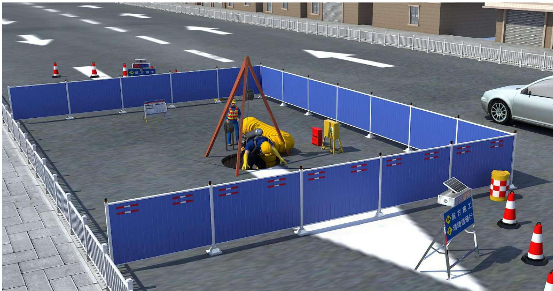
作业区域内部标准化（检查井维修施工）示意图
