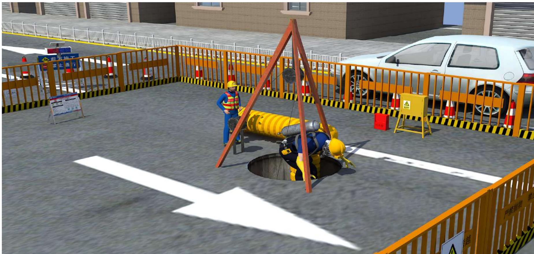
作业区域内部标准化（检查井维修施工）示意图
