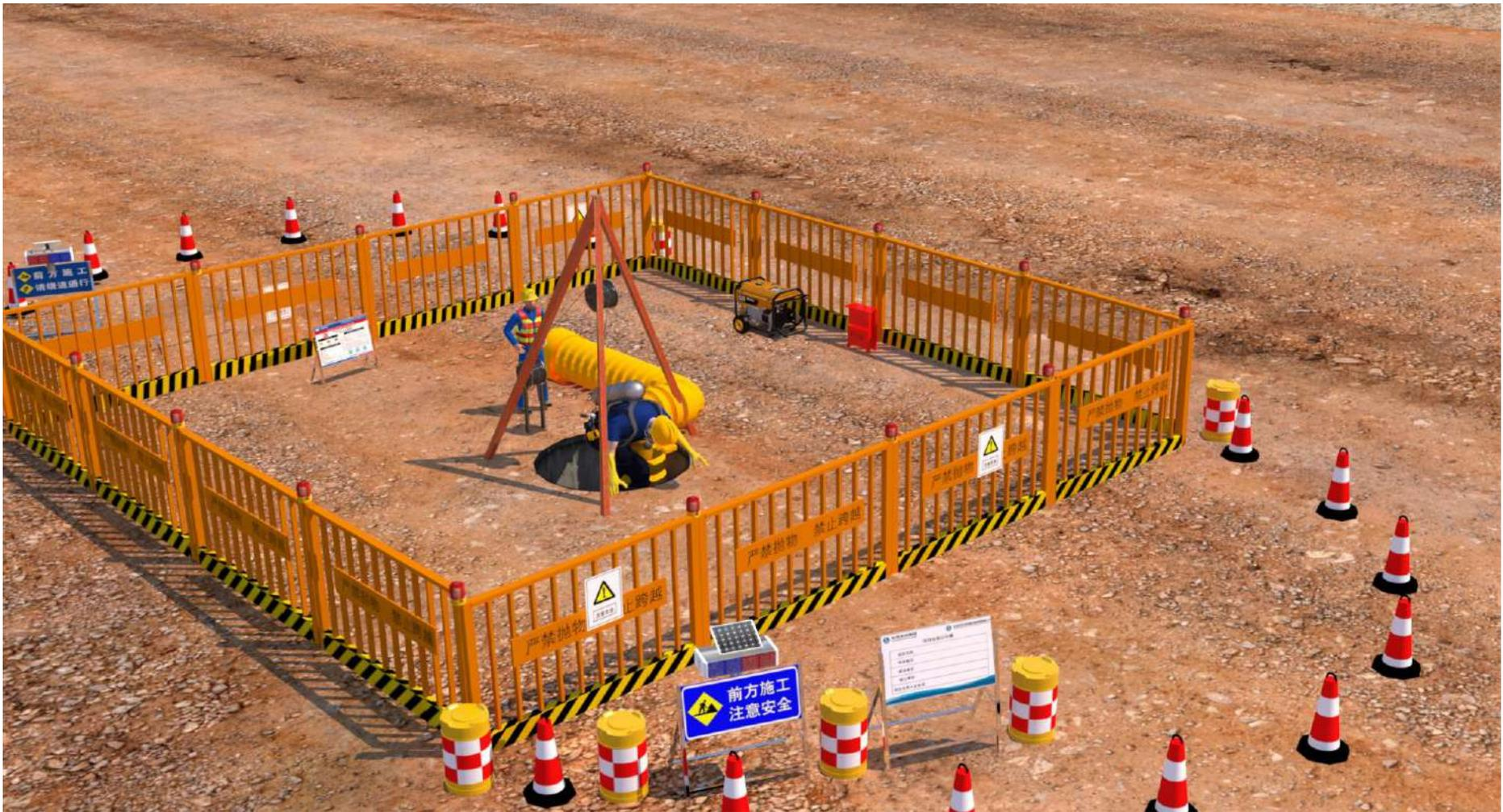
郊外管网维修工程（工期>1天）作业区域内部标准化（检查井维修施工）示意图
