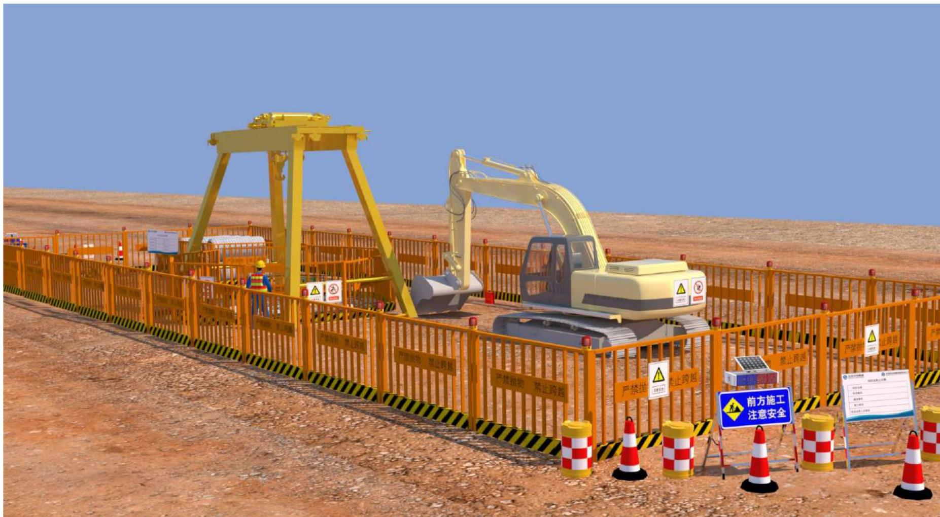
郊外管网维修工程（工期>1天）作业区域外围标准化示意图
