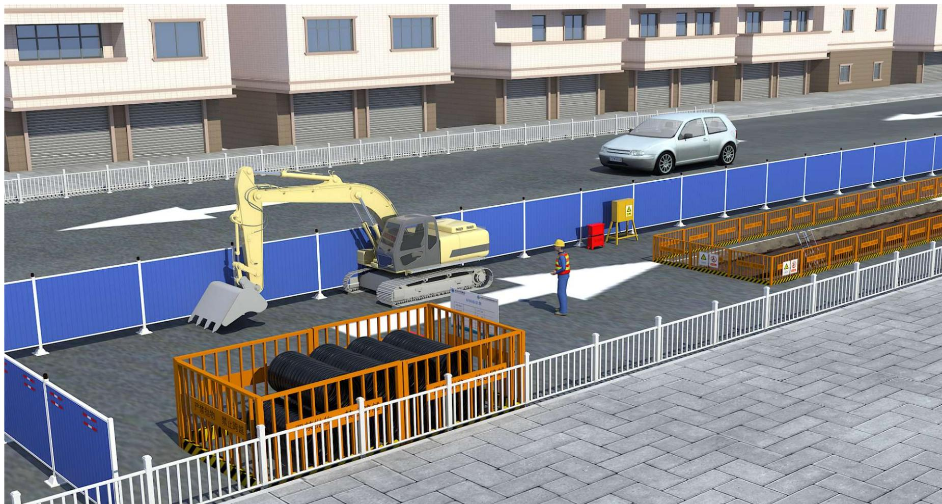
作业区域内部标准化（管道开挖施工）示意图(视角 2)
