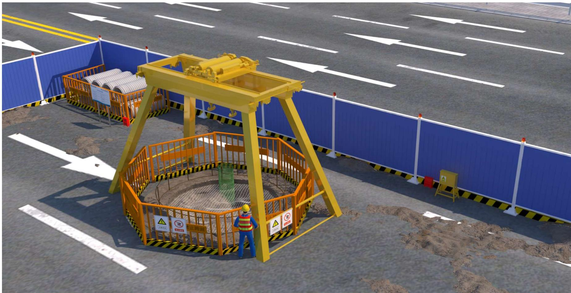
作业区域内部标准化（顶管施工）示意图
