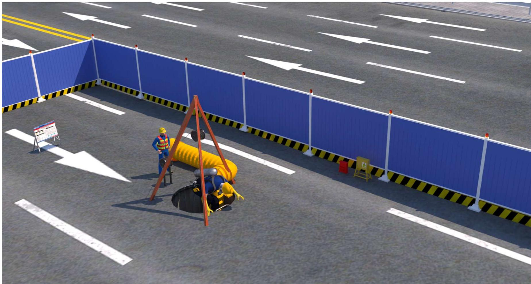
作业区域内部标准化（检查井维修施工）示意图
