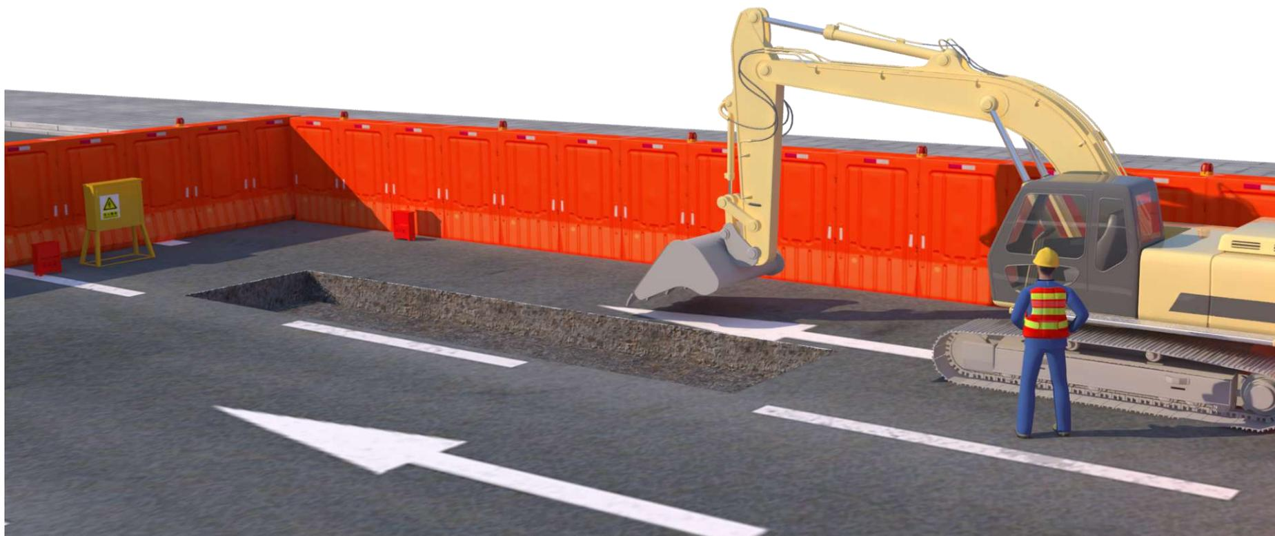
作业区域内部标准化（管道开挖施工）示意图
