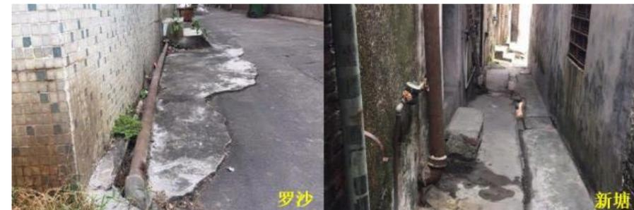
目前东莞市莞城街道供水管网整体建成年代久远,建设时间普遍在 20 年~30 年或 30 年以上,干管(管径大于等于 DN200)材料以砼、钢、铸铁等为主,管材较为落后,腐蚀老化现象严重,抢修维护成本较高;支管(管径小于 DN200)材料多以镀锌管和塑料管为主,随着使用时间的增加,镀锌管腐蚀情况严重。
