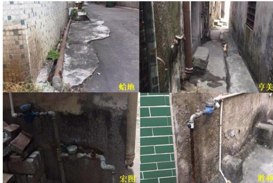
目前东莞市南城街道供水管网整体建成年代久远，建设时间普遍在 10 年~20 年或 20 年以上，干管（管径大于等于 DN200）材料以砼、钢、铸铁等为主，管材较为落后，腐蚀老化现象严重，抢修维护成本较高；支管（管径小于 DN200）材料多以镀锌管和塑料管为主，随着使用时间的增加，镀锌管腐蚀情况严重。
