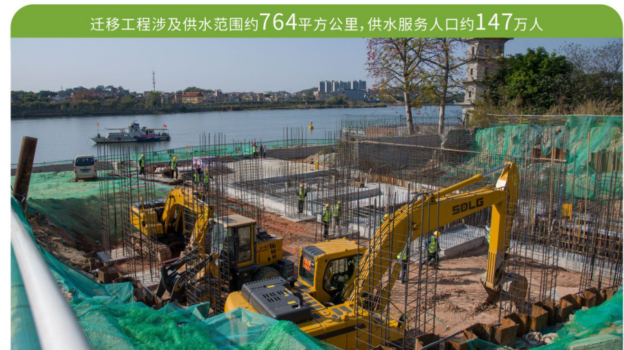
▲ 第二、第四水厂取水口迁移工程施工现场
