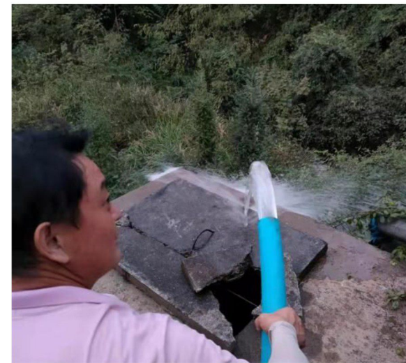
▲ 大坪村顺利接通第二水源
