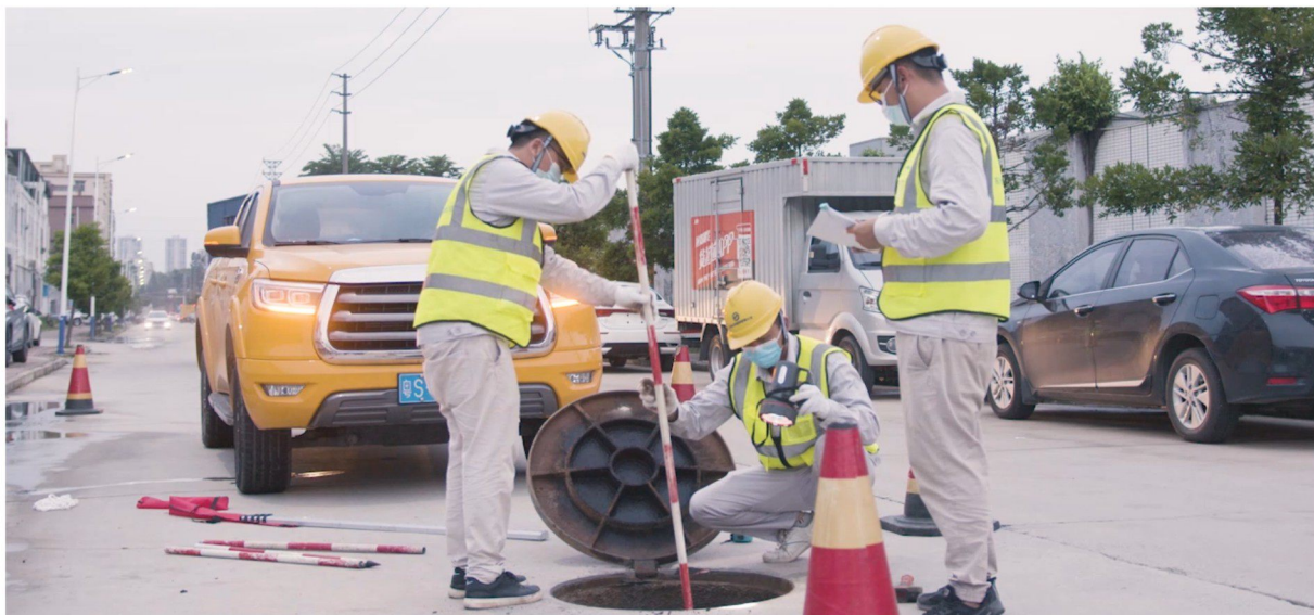
▲ 泵站阀门检修
