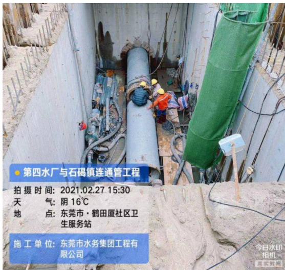
▲ 第四水厂与石碣镇连通管工程
