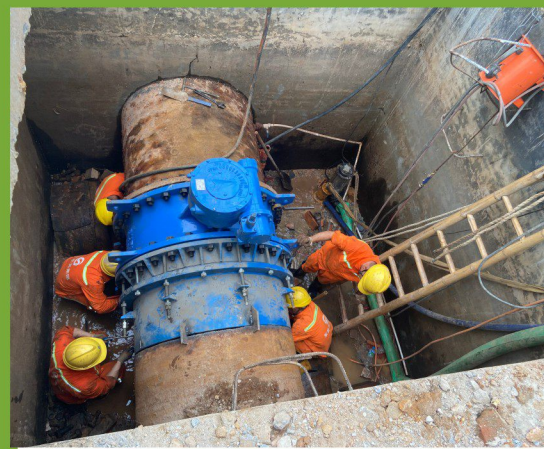
▲ 供水管网抢修
