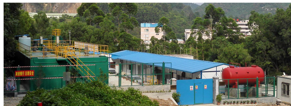
▼ 常平镇笑金坑生活垃圾填埋场渗滤液处理示范项目
