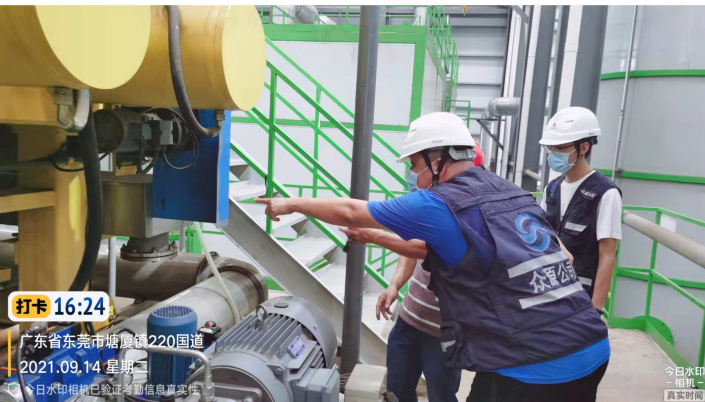
▲ 检查污泥处理处置设备运行情况
