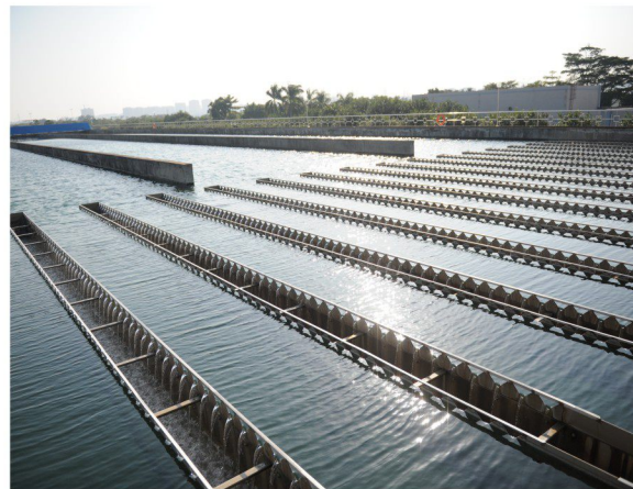
▲ 第三水厂平流池
