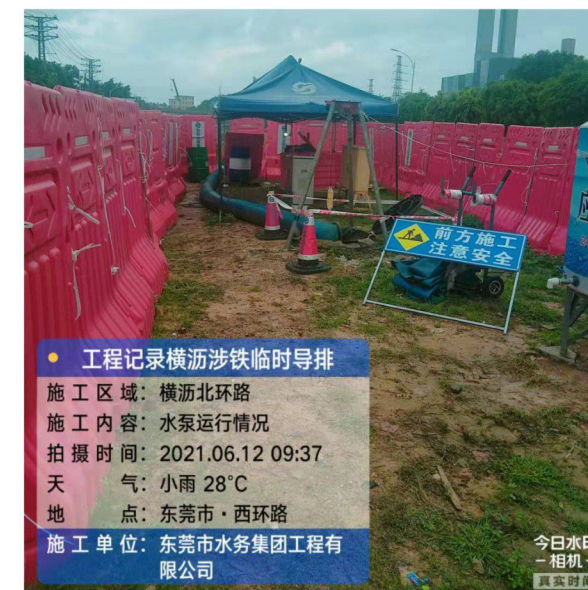
▲ 横沥镇涉铁截污主干网I线45#-46#井段污水导排项目
