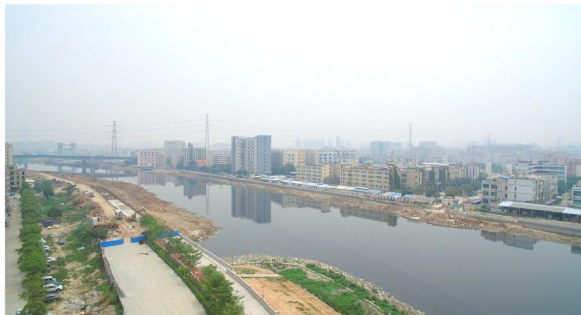
▲ 茅洲河界河段综合整治工程(东莞部分)第一标段治理前
