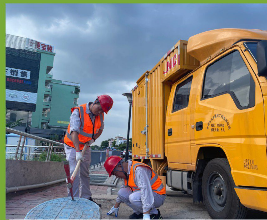
▲ 供水管网巡查
