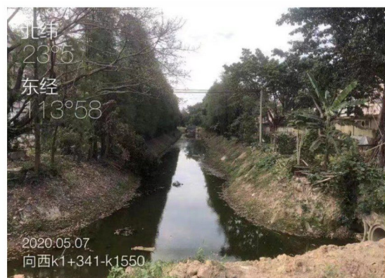
◀ 石排镇向西排渠整治前
