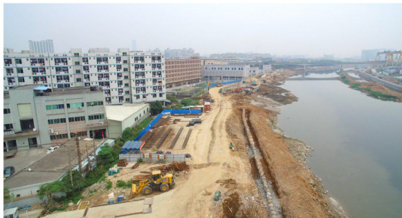
▲ 茅洲河界河段综合整治工程(东莞部分)第二标段治理前
