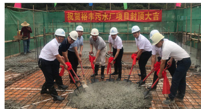
▲ 樟木头裕丰厂项目综合楼封顶仪式
