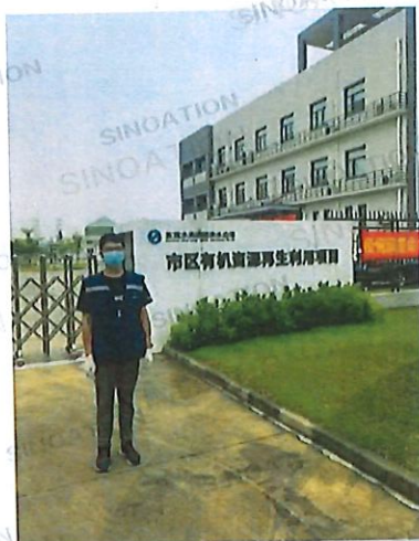
东莞市有机资源再生利用工程门口
