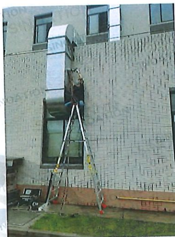
厨房油烟废气处理前
